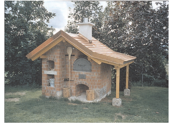
die gelungene Backofenanlage
